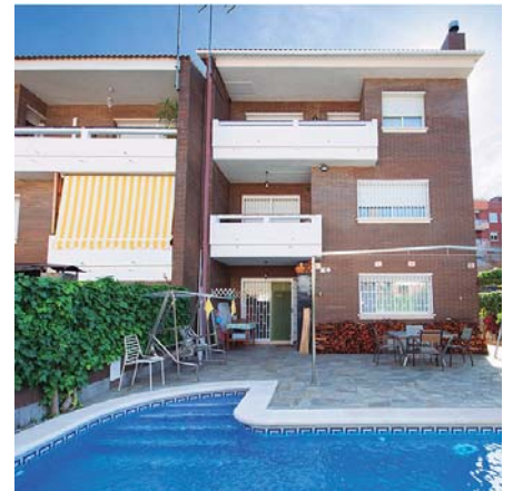
Casa esquinera en La Roureda - Viladecans
